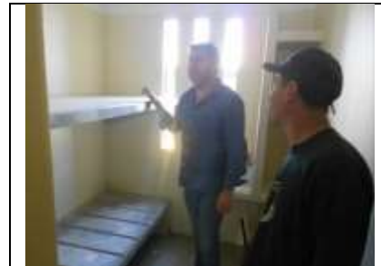
1. Se realizan reparaciones de Celdas de los modulo 51 al 56 y 76.
